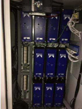
Die Anlage ist mit zehn Ultraschallsystemen ausgestattet, die für den Dauerbetrieb ausgelegt sind.
